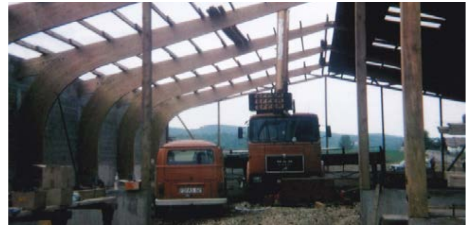
Erste Schritte zum Bau der Reithalle und des anschließenden Stalles
